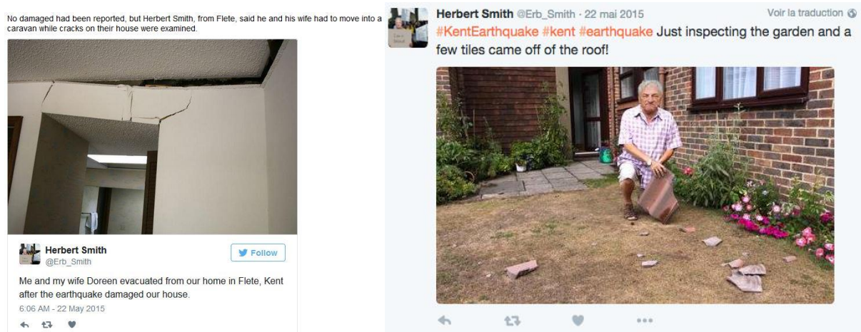
Figure 5 – Dommages observés à Flete (12km de l'épicentre).
